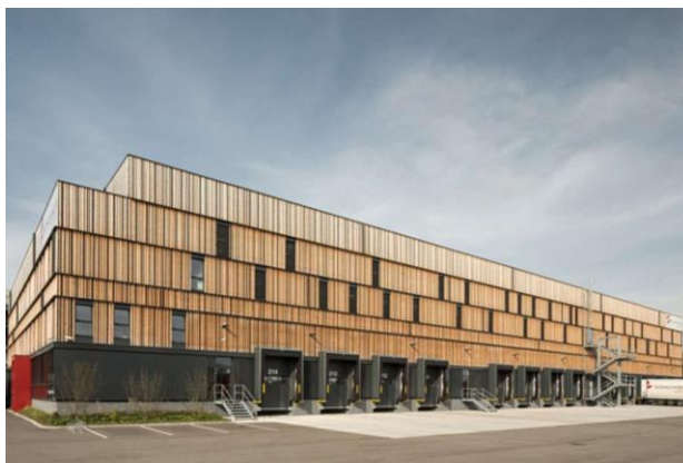
Slika 18: Logistična dvorana podjetja Schachinger.
